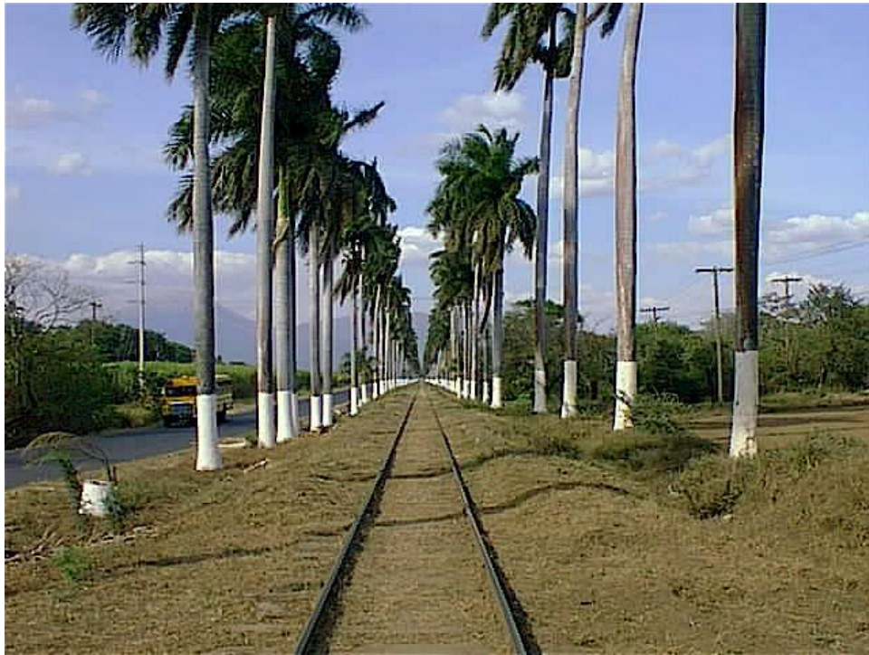
Vía Ferrea entre el ISA y Chichigalpa
