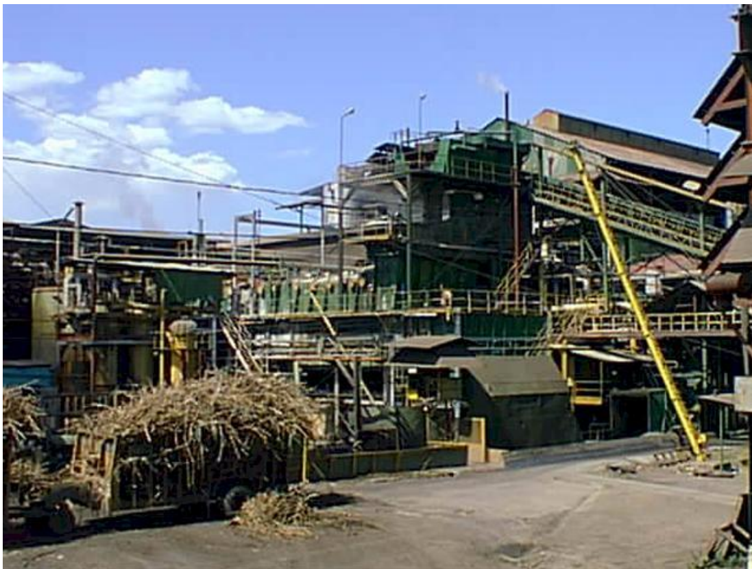
Descarga de Caña en Fábrica
