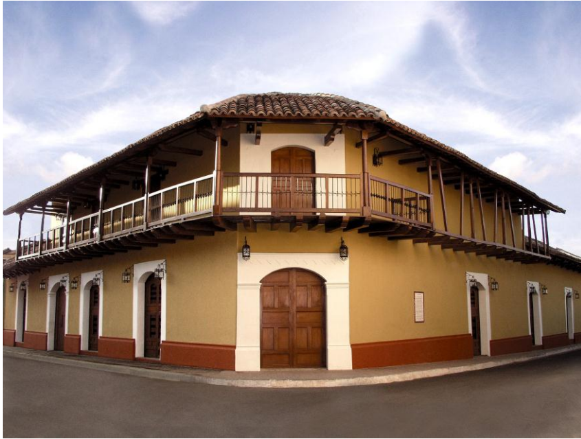
Fachada de La Gran Francia
