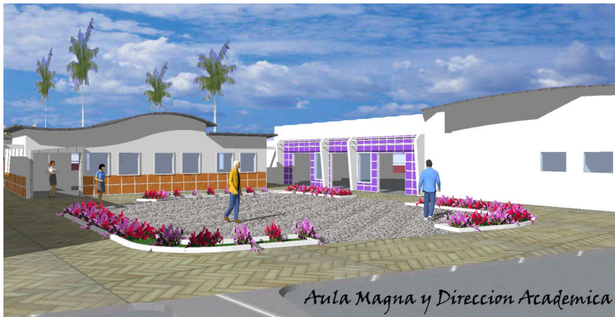
Ilustración 95 Edificio "Aula Magna" Fuente: Propia
