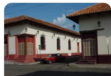
Foto No.72 /Vista Exterior
