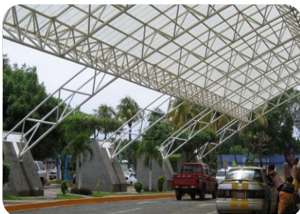
Foto No.98 /Estructura de Techo
