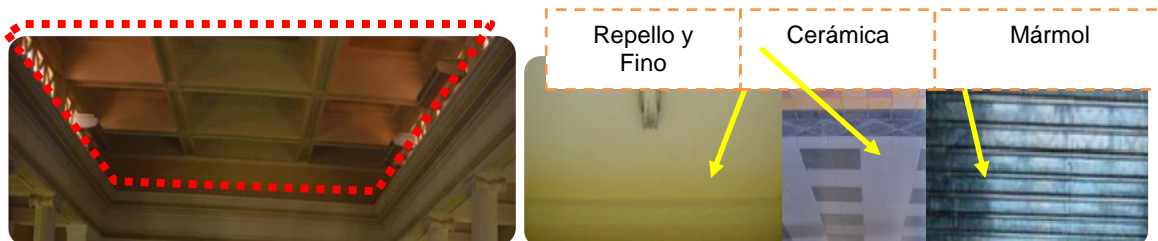
Foto No.59 Cielo Falso de losa expuesta de Concreto Armado
