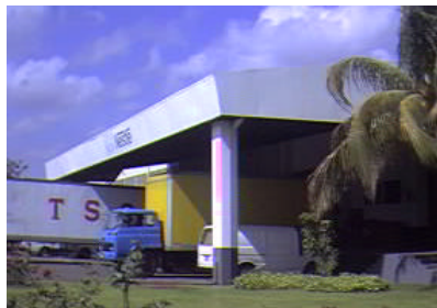
Area de carga y descarga
