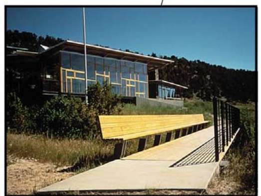
FOTO # 31 COMEDOR - PUENTE PEATONAL
