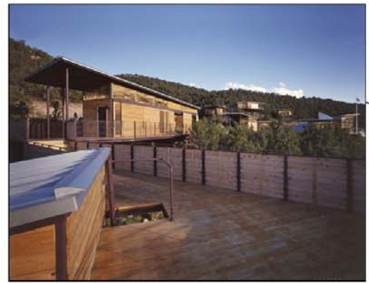
FOTO # 27 PUENTE DE COMUNICACION ENTRE CABINAS
