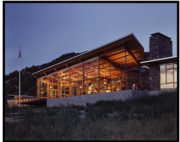
Foto No. 24: Vista de Comedor, Camp. Paint Rock
