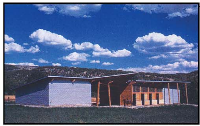
FOTO # 28 VISTA ESTABLOS
