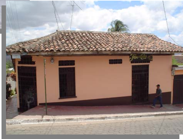
Foto N° 06: Techos de teja típicos de la ciudad de Juigalpa
