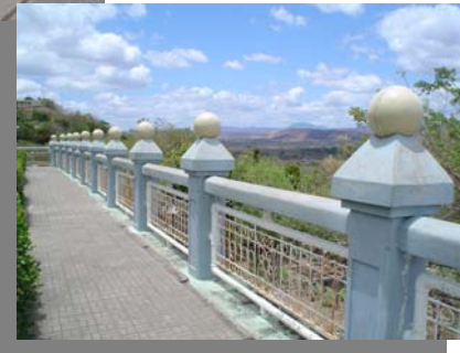
Foto N° 10: Detalle de baranda del Restaurante Palo Solo
