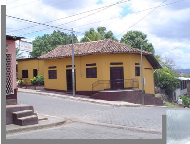
Foto N° 05: Techos de teja típicos de la ciudad de Juigalpa
