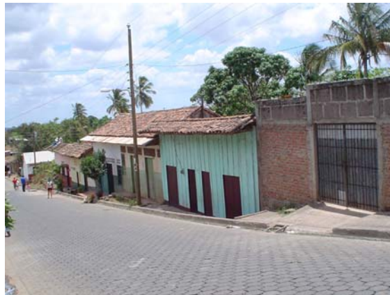
Foto N° 04: Techos de teja típicos de la ciudad de Juigalpa
