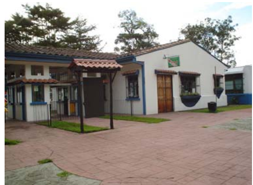
Foto N° 53: Vista Interna hacia taquillas
