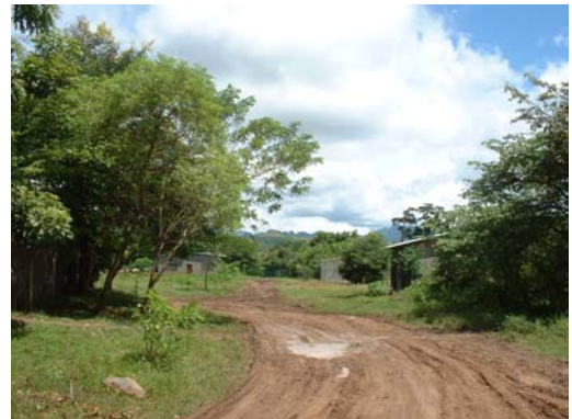
Foto N° 35: Mal estado de las vías en meses de invierno
