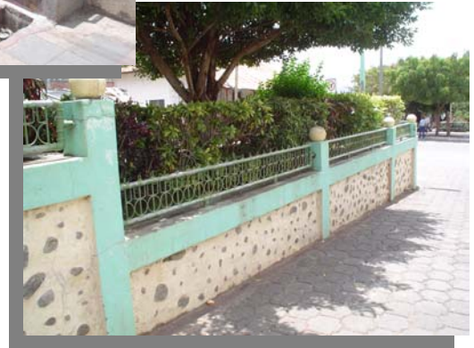
Foto N° 20: Detalla de revestimiento de piedra laja en jardineras cerca de la Catedral
