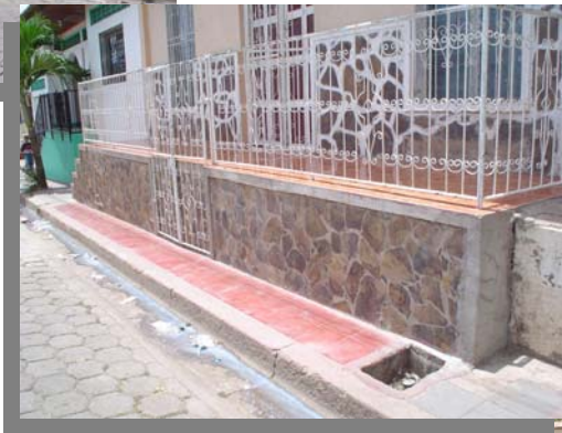
Foto N° 19: Detalla de revestimiento de piedra laja
