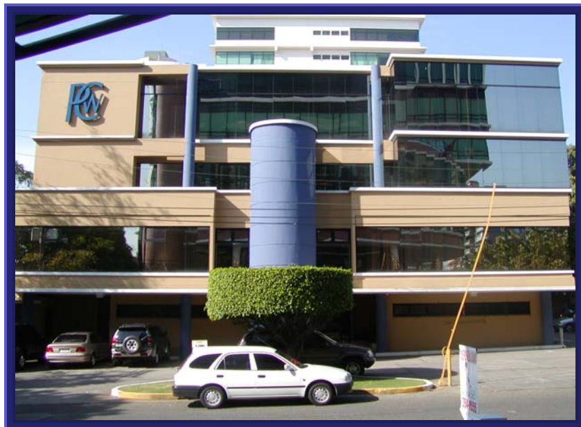
Foto No 1: Fachada Principal del Edificio
