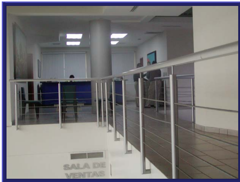
Foto No 13: Detalle de barandas con tensores
