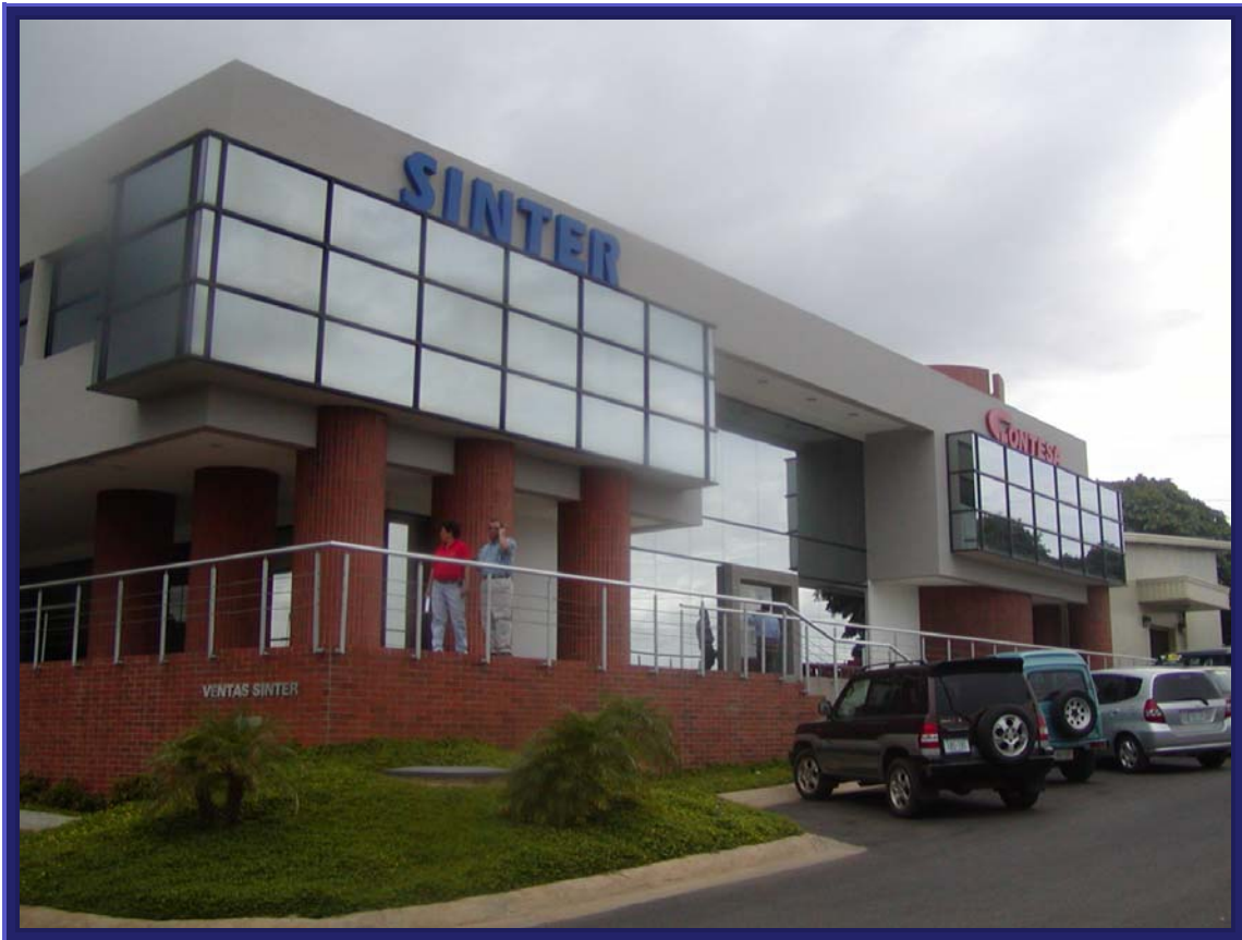
Foto No 7: Fachada principal del edificio
