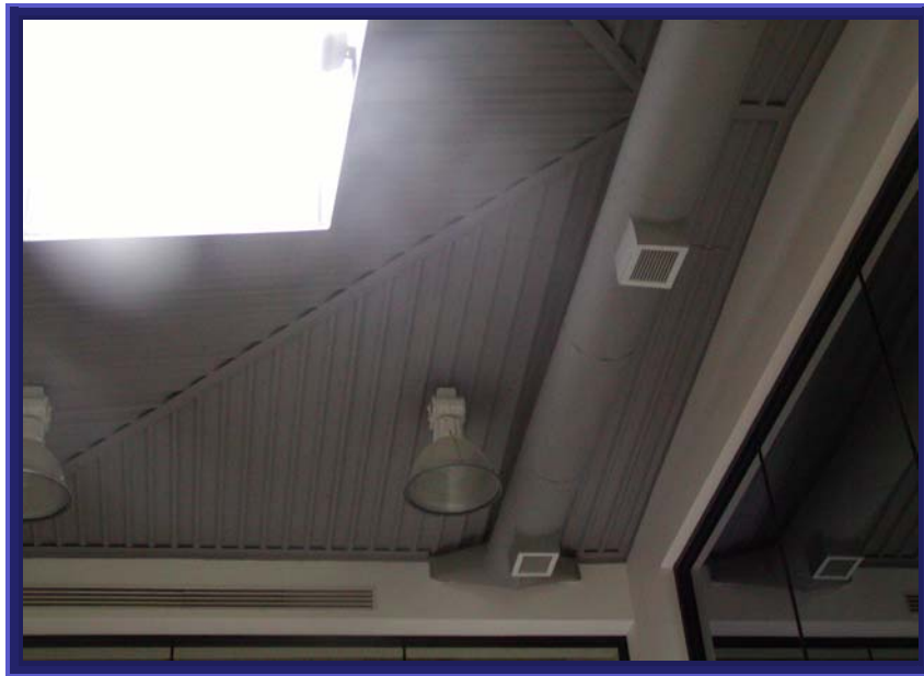
Foto No 12: Detalle de cielo del edificio
