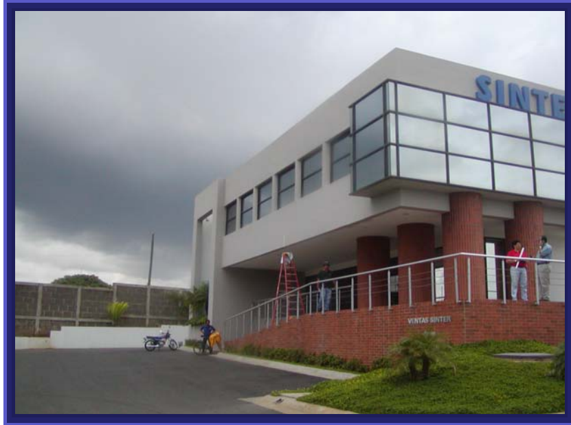
Foto No 8: Vista del costado sur del edificio
