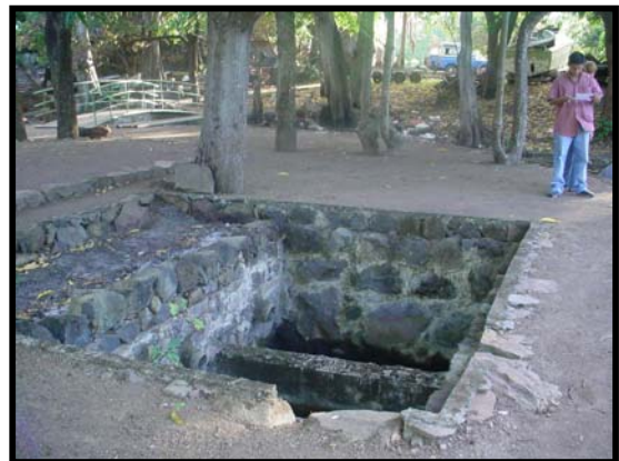
Foto N° 33. Fosa de Aguas Pluviales.
