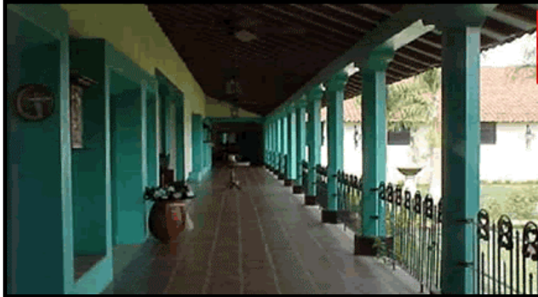
Foto N°20 Pasillo interno que vincula las habitaciones con jardín interno
