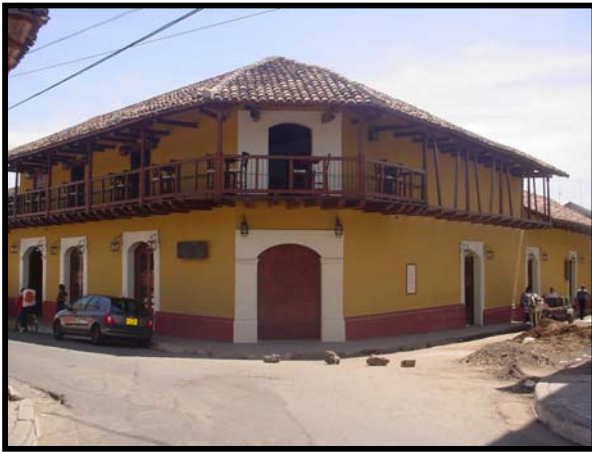
Foto 10 Vista del Hotel La Gran Francia-
